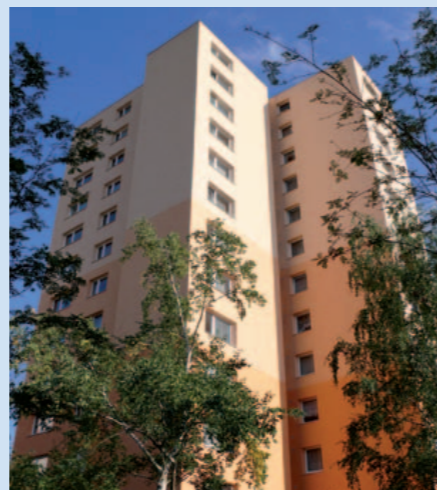
Bytový dům ve Vlnařské ulici na sídlišti Broumovská
