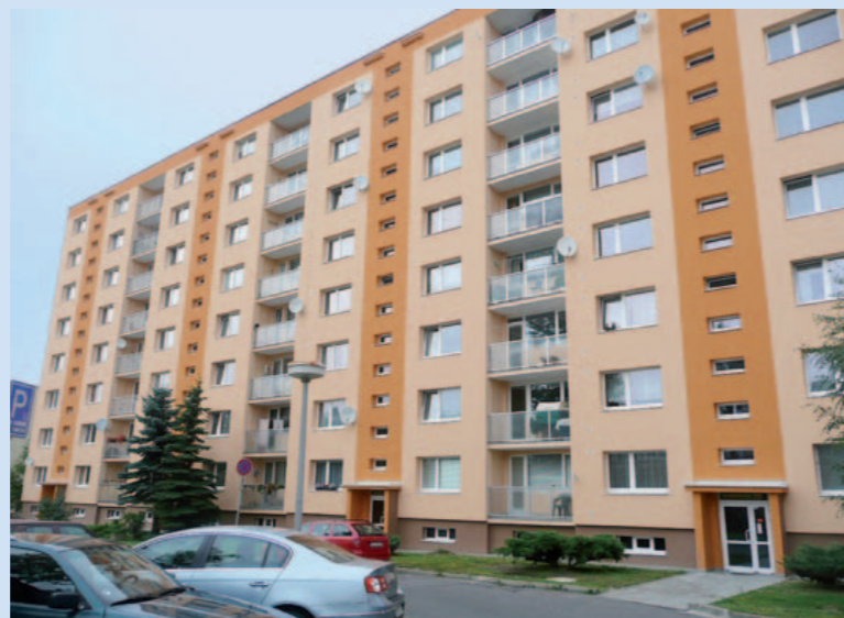
Zateplení a výměna okem domů v ulici Sněhurčina
