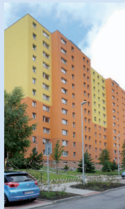
Dům v Pazderkové ulici zrekonstruovaný z dotačního programu Panel
